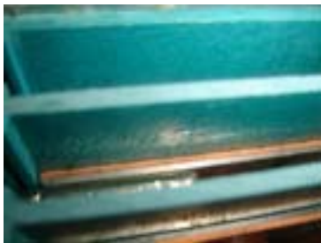
圖 4-C 接頭內水滴發霉現象
