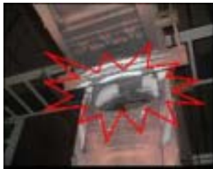
圖 3-A 匯流排事故照片
