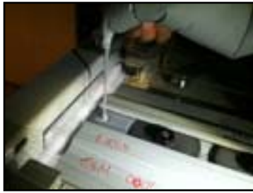
圖 6-D 接頭填充絕緣 silicon
