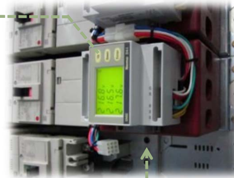
分路開關電力模組 Branch PM Module
